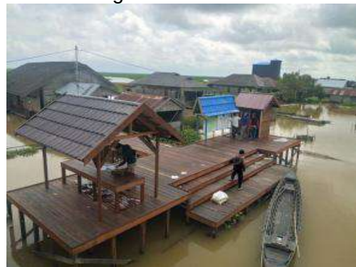
Pembangunan Dermaga Angkutan Sungai
