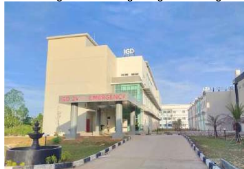
Pembangunan RSUD Baru
