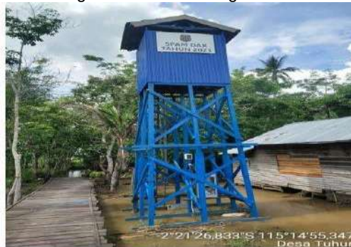
Pembangunan Sistem Penyediaan Air Minum
