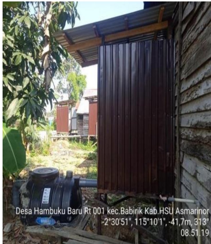
Gambar 3. 7 Pembangunan Tangki Septik Skala Individual Perdesaan
