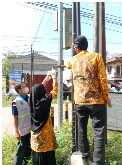
Gambar 3.8 Pemasangan alat pemantauan kualitas udara metode passive sampler di lokasi pemantauan Simpang Empat Banua Lima
